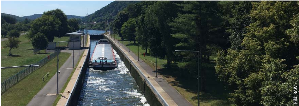
Die Mainschleuse in Rothenfels ist mit 90 Jahren eines der vielen noch intakten älteren Wasserbauwerke. Instandhaltung und Ertüchtigung dieses Bestands leisten einen großen Beitrag zum Klimaschutz
